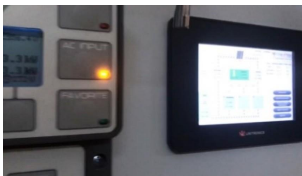
Ilustración 1: Acceso local a la instalación
